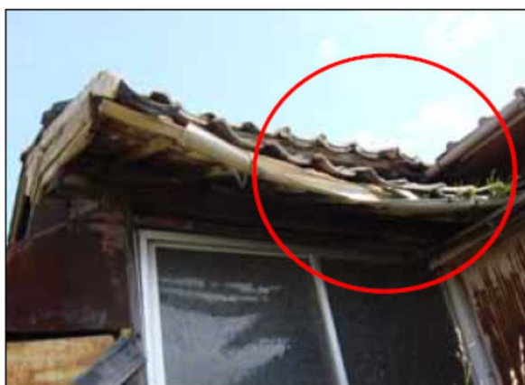
屋根が変形している、軒や雨樋が 垂れ下がっており、落下飛散の恐れがある例 (屋根ふき材、ひさし又は軒)
