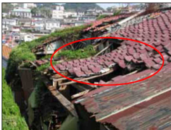
屋根、ふき材が剥落している例 (屋根ふき材、ひさし又は軒)
