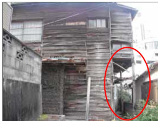
柱に局所的な亀裂やひび割れ等がある例 (柱、はり、筋かい、柱とはりの接合等)
