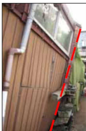
建物の傾きが明らかに確認できる例 (建築物の著しい傾斜)
