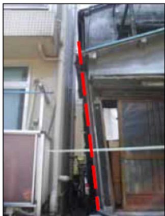
建物の傾きが明らかに確認できる例 (建築物の著しい傾斜)
