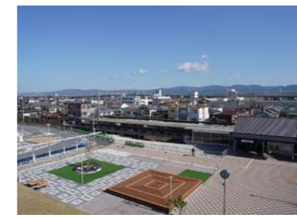
結崎駅の駅舎の移転工事、及び結崎1号踏切拡幅にかかる用地買収等を行いました。
