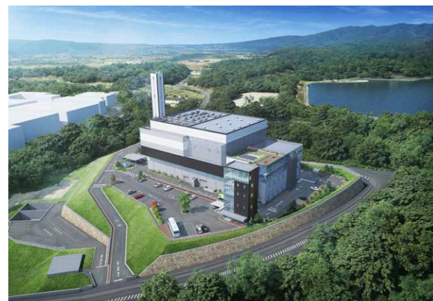
エネルギー回収型廃棄物処理施設
