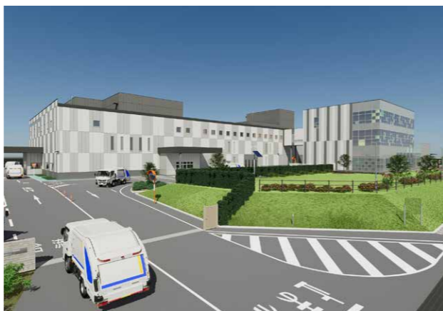
マテリアルリサイクル推進施設
