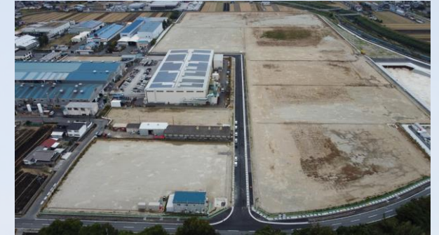
唐院工業団地のエリアを拡張する事業を実施しました（12ha）。今後、拡張したエリアに企業が立地していきます。
