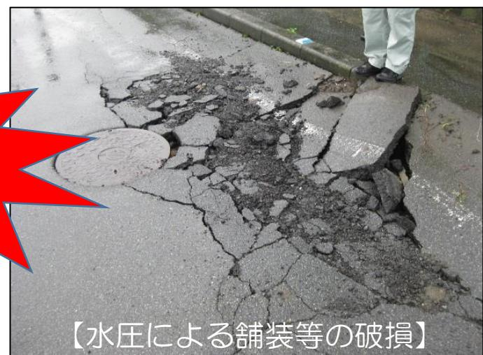
【水圧による舗装等の破損】
