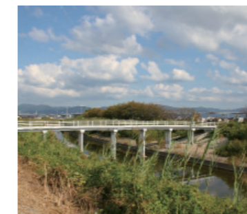
橋梁長寿命化修繕計画に伴い、つつみ橋の補修工事を行いました。
