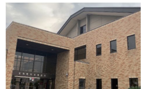
指定緊急避難場所である中央体育館の改修工事が完了しました。
