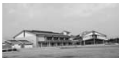
平成24年度から本格的にスタートした改築工事により、平成26年度に屋内運動場・プール棟が完成しました。
