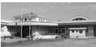
教育施設改善の一環として、幼稚園の空調改修工事を行いました。
