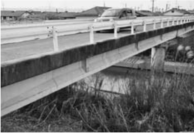
▲こおろぎ橋の長寿命化対策
