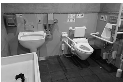
改修された駅の多目的トイレ
