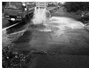
(マンホールからの下水噴出)
