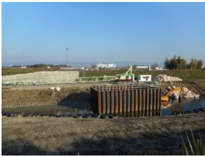
天理王寺線橋梁下部工事の様子 （河合町から川西町を望む）
