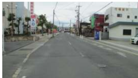
歩道の整備状況(町道結崎線)
