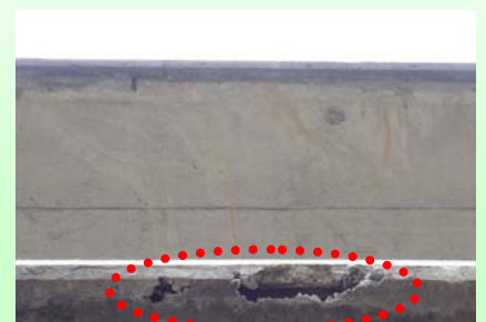
主桁の損傷（剥離）
